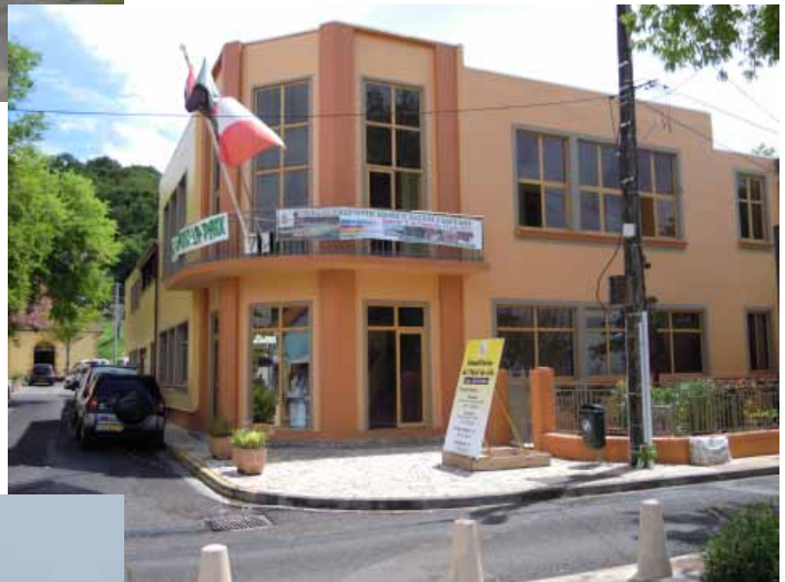
Hôtel de ville rénovée - Saint-Anne
